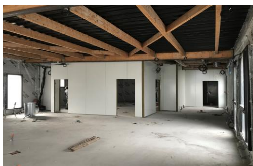
L'intérieur du restaurant avec la cloison coupe-feu entre cuisine et réfectoire
