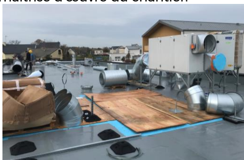
Toiture avec tous les organes techniques pour le fonctionnement du bâtiment
